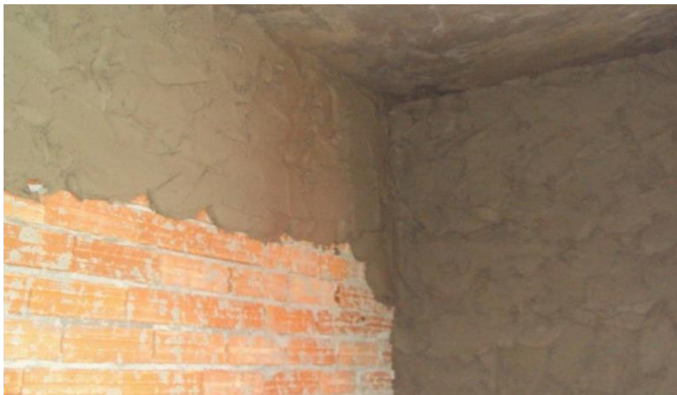
Figura 13. Aplicação da argamassa no substrato
