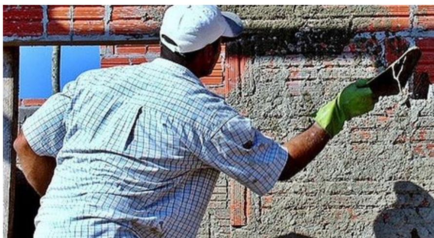
Figura 7. Aplicação do chapisco no substrato
