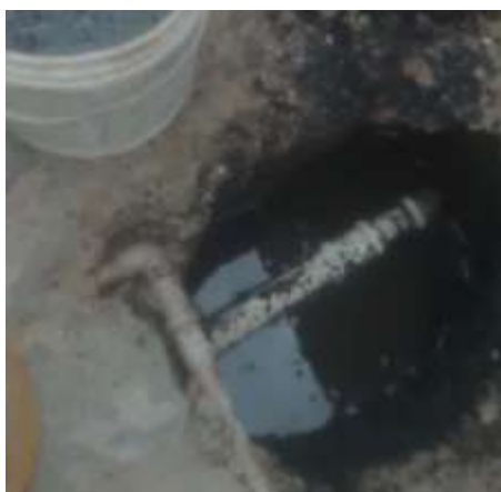
Imagem 6 tubulações encontradas na laje
