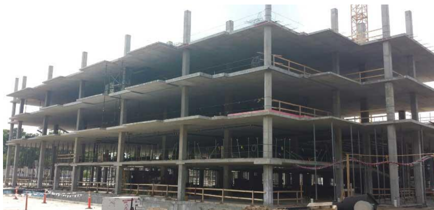
Figura 2 – Exemplo de estrutura feita em concreto armado.
