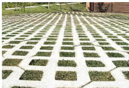
Figura 1 – Pavimento com revestimento constituído por peças de concreto com áreas vazadas.
