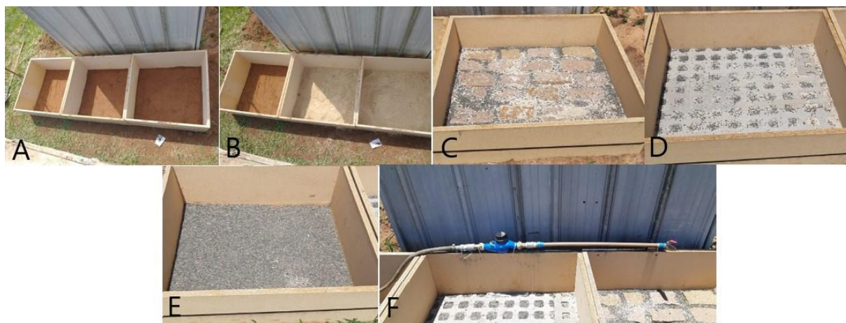
Figura 4: Processos de instalação
