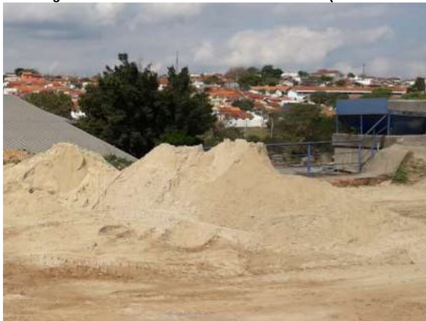
Figura 2: CENTRAL DE AGREGADOS MIÚDO (AREIA GROSSA)
