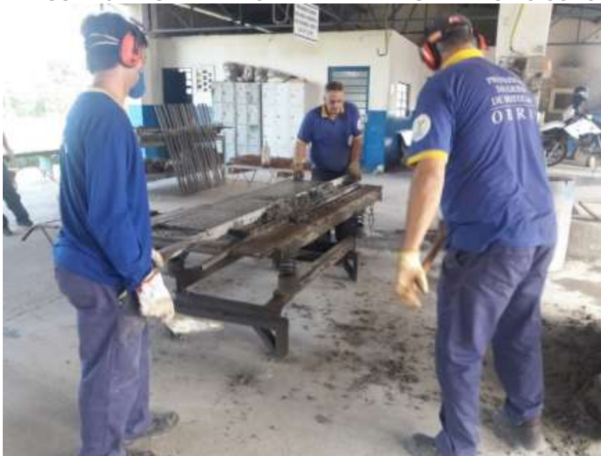
FIGURA 6: MESA VIBRATÓRIA PARA ADENSAMENTO DO CONCRETO
