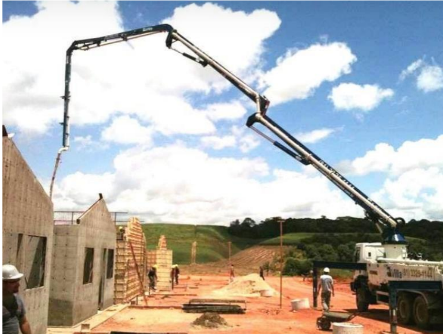
Figura 10. Concretagem. Fonte: USIMAK (2012).
