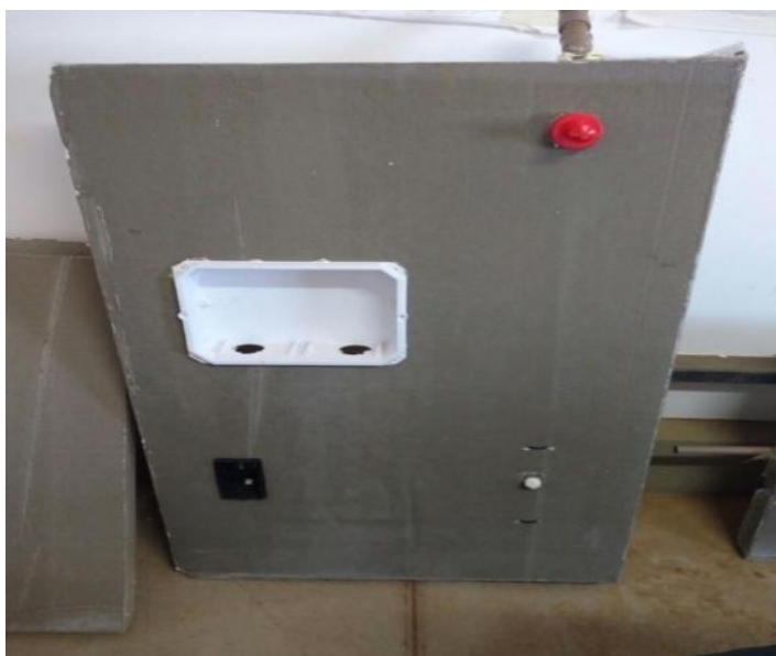
Figura 15. Placas de shafts em EPS com tubulação hidráulica. Fonte: OLIVEIRA et al (2019).
