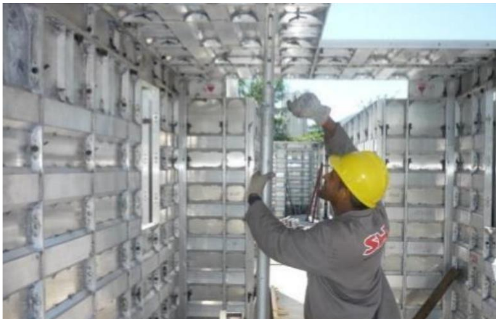
Figura 9. Montagem da forma. Fonte: OLIVEIRA et al. (2016).
