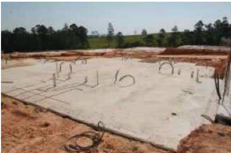
Figura 5. Radier de uma obra executada em parede de concreto. Fonte: COMUNIDADE DA CONSTRUÇÃO (2012).
