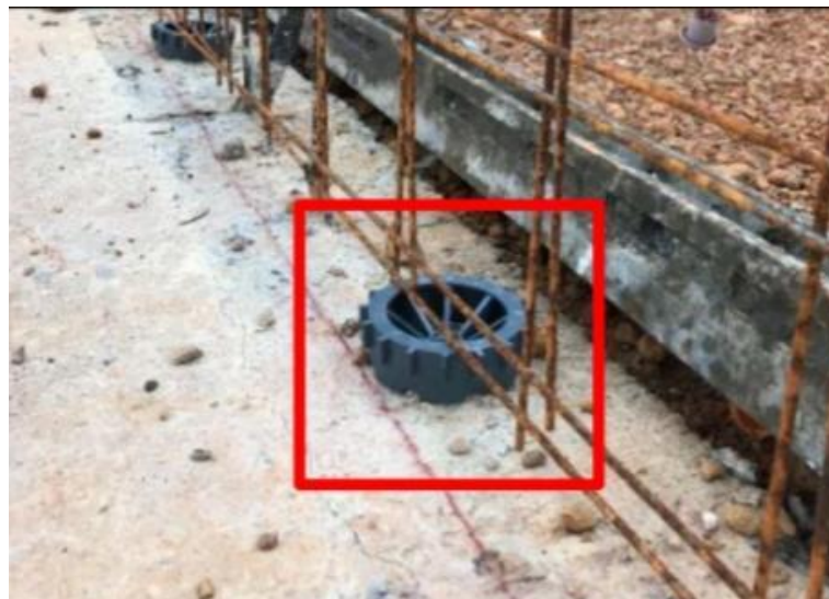
Figura 7. Colocação dos distanciadores. Fonte: FRANÇA, 2019).
