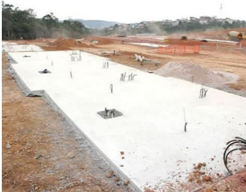
Figura 4. Fundação nivelada com arranques. Fonte: COMUNIDADE DA CONSTRUÇÃO (2020).
