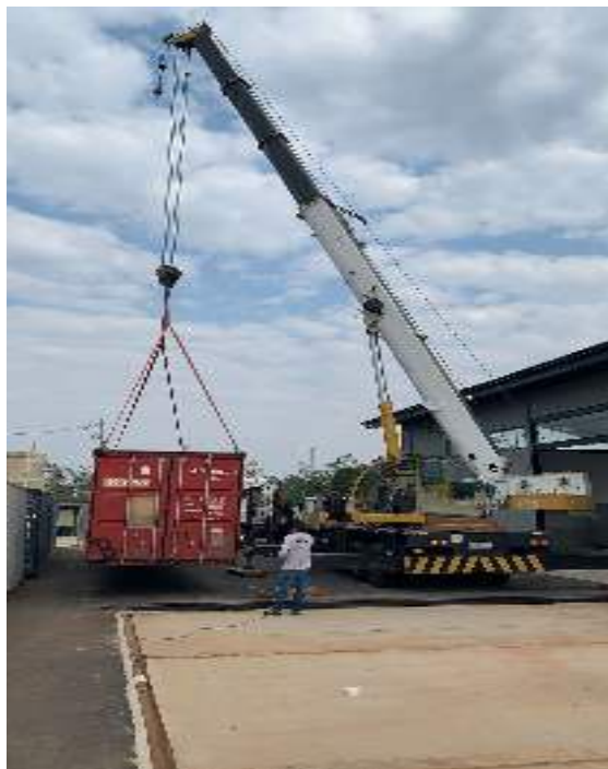
Figura 17 Guindaste transportando o container até o radier, Parque Tecnológico de Botucatu, SP . Fonte: Autor. 2021.
