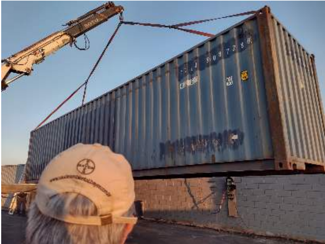
Figura 16 Elevação do container pelo guindaste. Parque Tecnológico de Botucatu, SP. Fonte: Autor. 2021.
