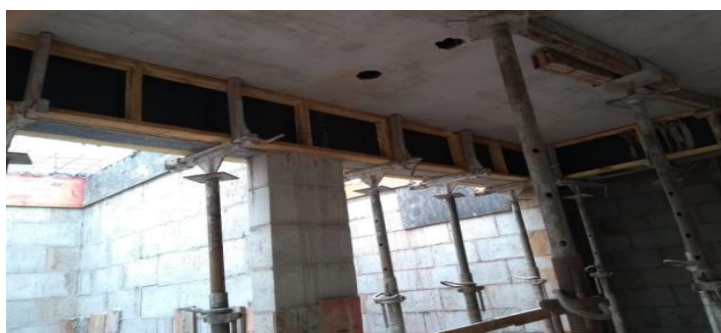
FIGURA 2 – Fôrmas instaladas no segundo pavimento do empreendimento
