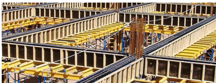
FIGURA 6 – Fôrma pronta das vigas instaladas e escoradas
