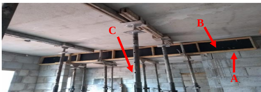
FIGURA 5 – Fôrma das vigas instaladas e escoradas.
