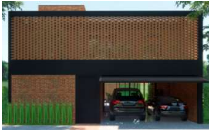
Figura 55 - Fachada com paredes de cobogó de tijolos. Fonte: Autora (2020).
