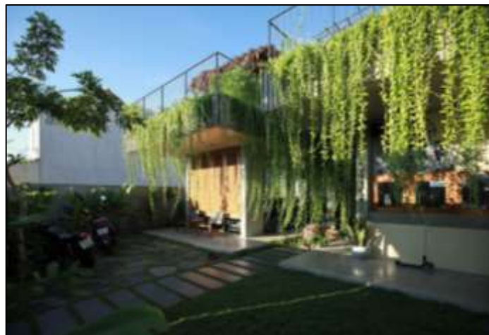
Figura 6 - Residência SKB. Foto: Duong Van Mau. Fonte: Archdaily (2020).
