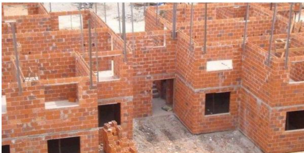
Figura 3 – Sistema de alvenaria UNICHRISTUS (2016).– Adaptado
