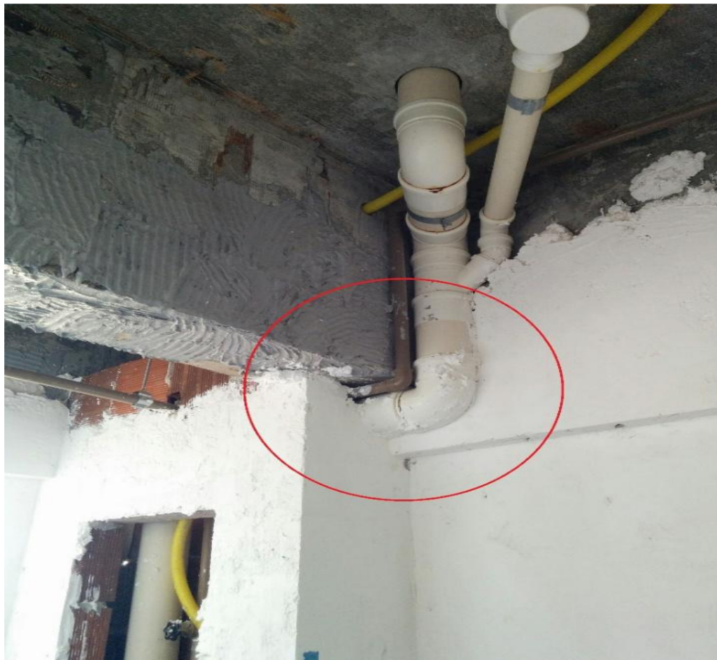
Figura 8 - Tubulação da bacia sanitária sendo passada por baixo da viga. (fonte: revista campo do saber issn 2447-5017)
