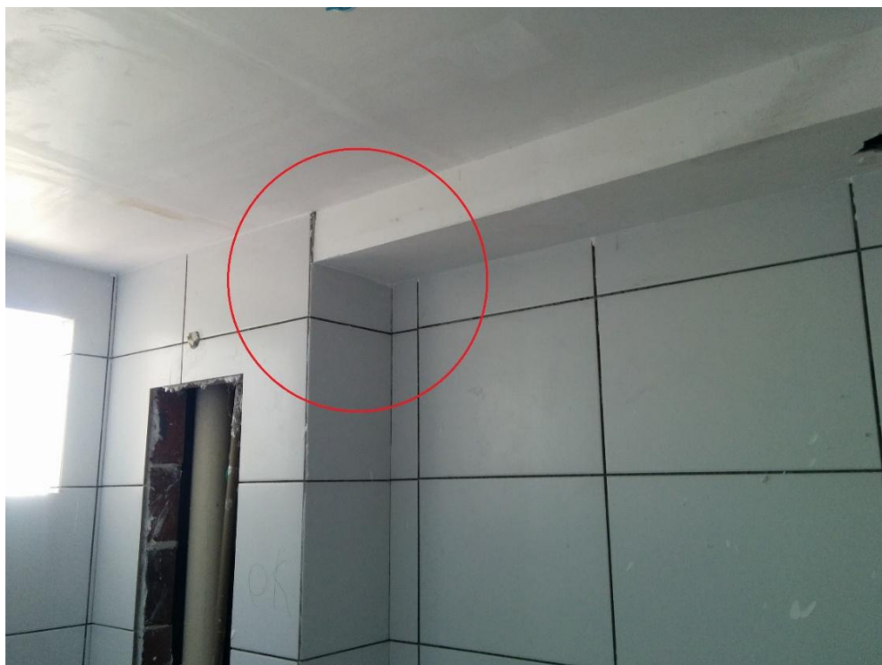
Figura 9 - Banheiro com o forro de gesso colocado. (fonte: revista campo do saber issn 2447-5017)
