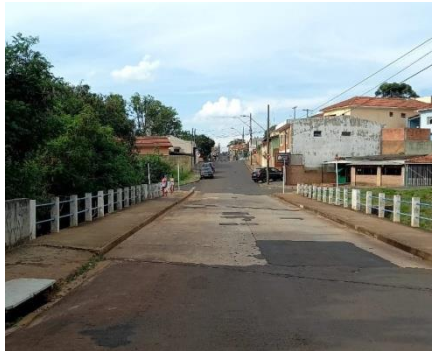
FIGURA 2 - Ponte localizada na Rua Curuzu da cidade de Botucatu, SP.
