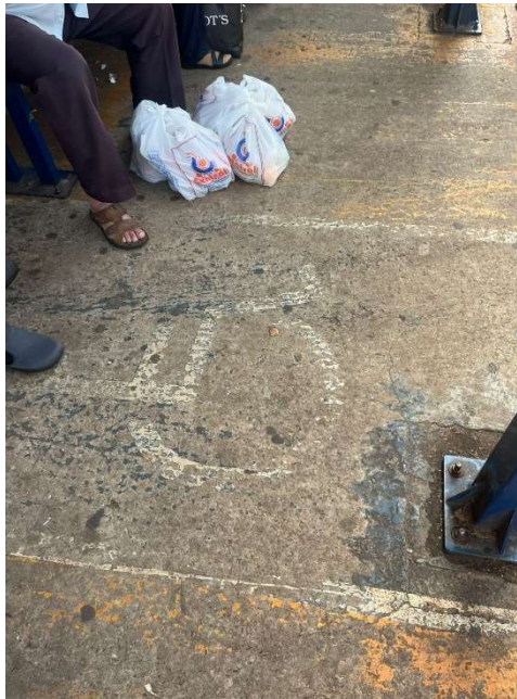
Figura 48 – Sinalização posição de cadeirante no ponto de ônibus
