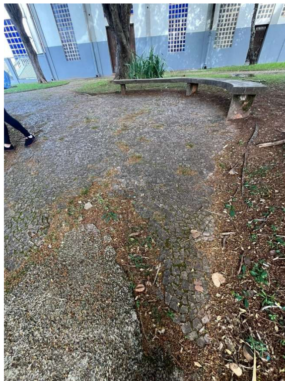
Figura 36 – Caminho de pedras com manutenção feita em concreto
