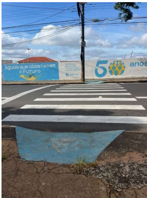
Figura 16 – Rampa de acesso e faixa de pedestre na calçada frontal
