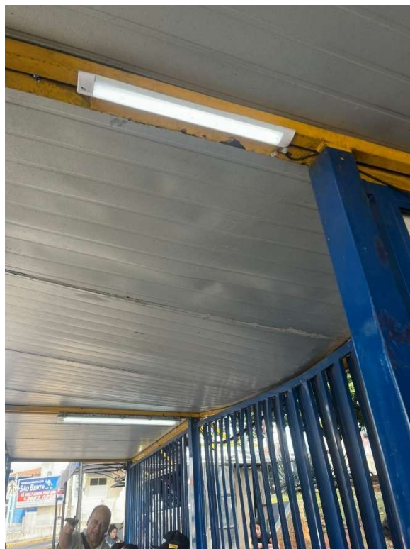
Figura 26 – Iluminação e cobertura do ponto de ônibus
