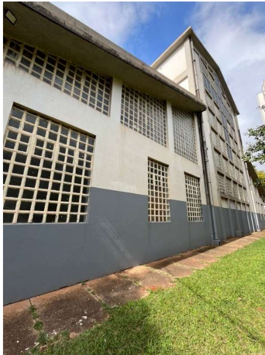
Figura 44 – Fachada fundos da paróquia
