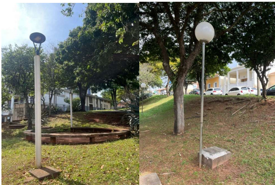
Figuras 13 e 14 – Postes de iluminação (modelo mais recente e o antigo)
