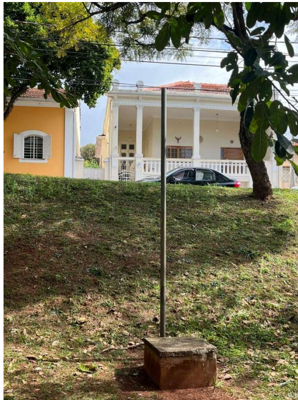
Figura 29 – Poste de iluminação danificado (sem iluminação) nos fundos da praça
