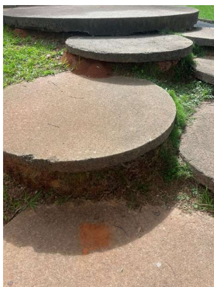
Figura 17 – Patamares de acesso laterais
