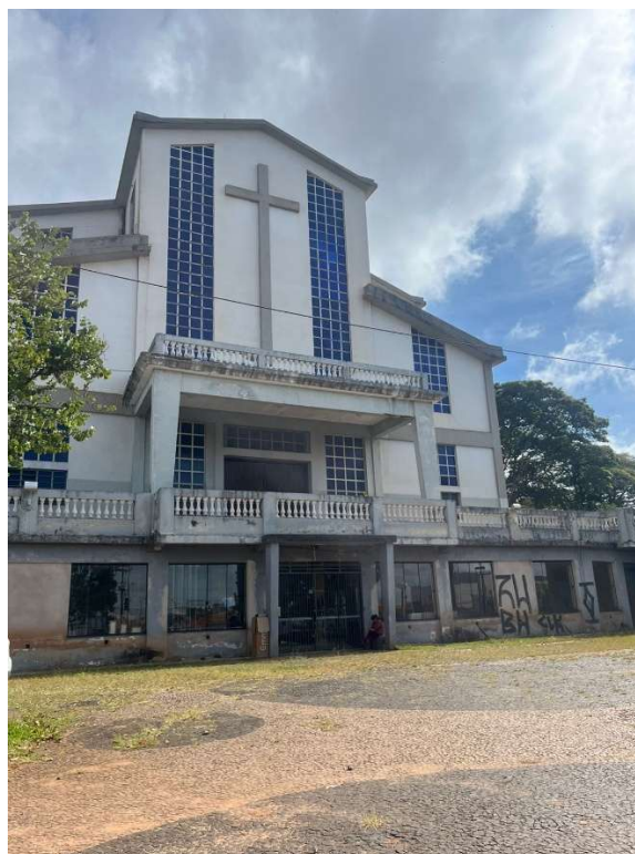
Figura 43 – Fachada frontal da paróquia
