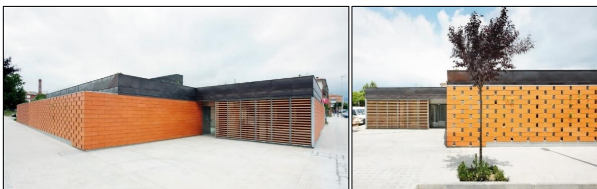
Figura 08 – Fachada principal (acima) e volumetria da construção (abaixo) do Centre de Dia Municipal Les Teixidores .
