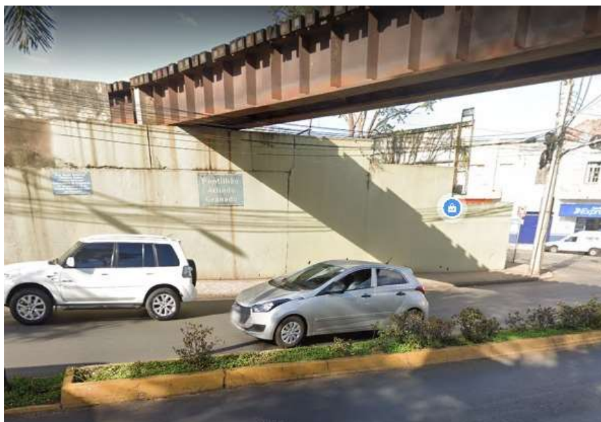
Figura 11 Parede do Pontilhão. Botucatu/SP. Fonte: Google Maps, 2021.
