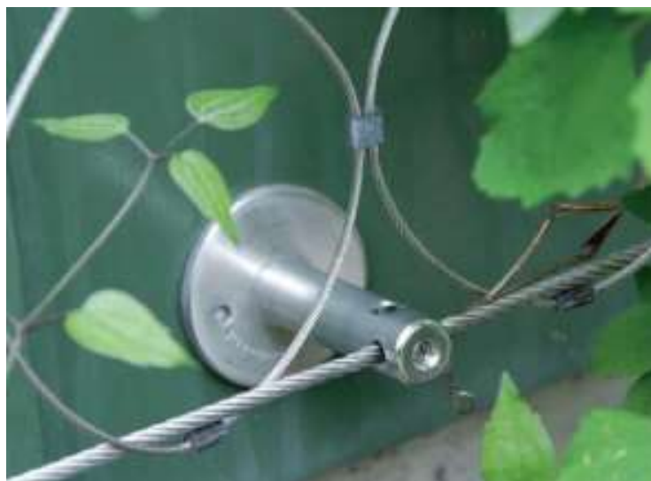
Figura 4 Fachada Indireta de Rede de Cabos Fonte:Site InkMason (2015)
