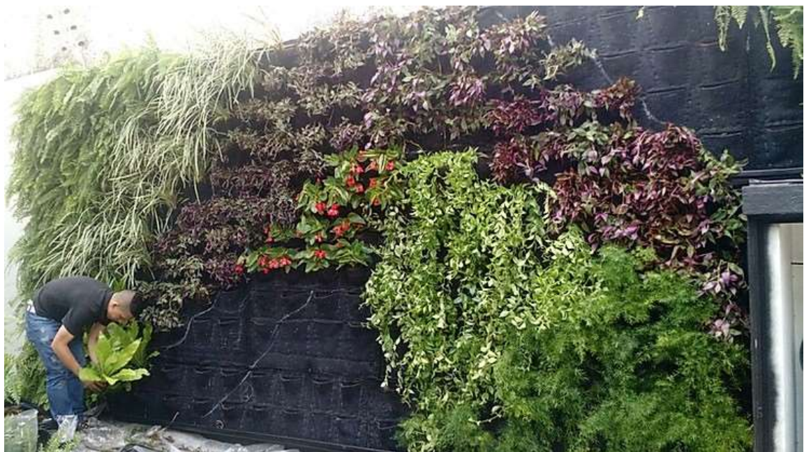
Figura 13 Manta geotêxtil instalada na parede. Fonte: Vertical Garden, 2021.
