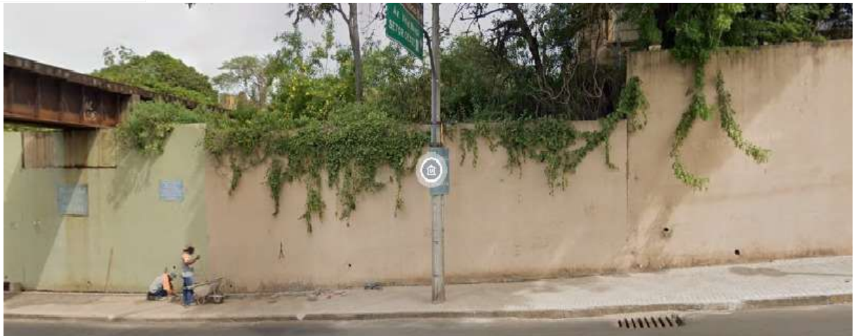
Figura 12 Comprimento do muro do pontilhão. Botucatu/SP; Fonte: Google Maps, 2021.
