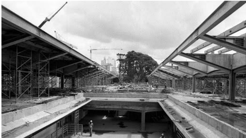
Figura 3 - Construção do Centro Cultural São Paulo
