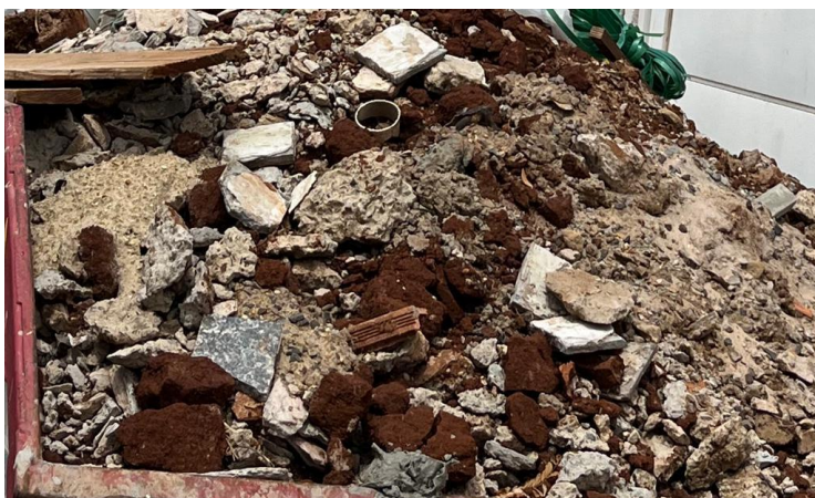
Figura 6. Entulho gerado por um dos locatários – demolição, em Jaú, SP.
