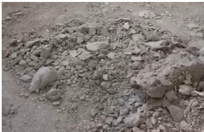
Figura 2. Entulho gerado após a finalização de um cômodo do apartamento.
