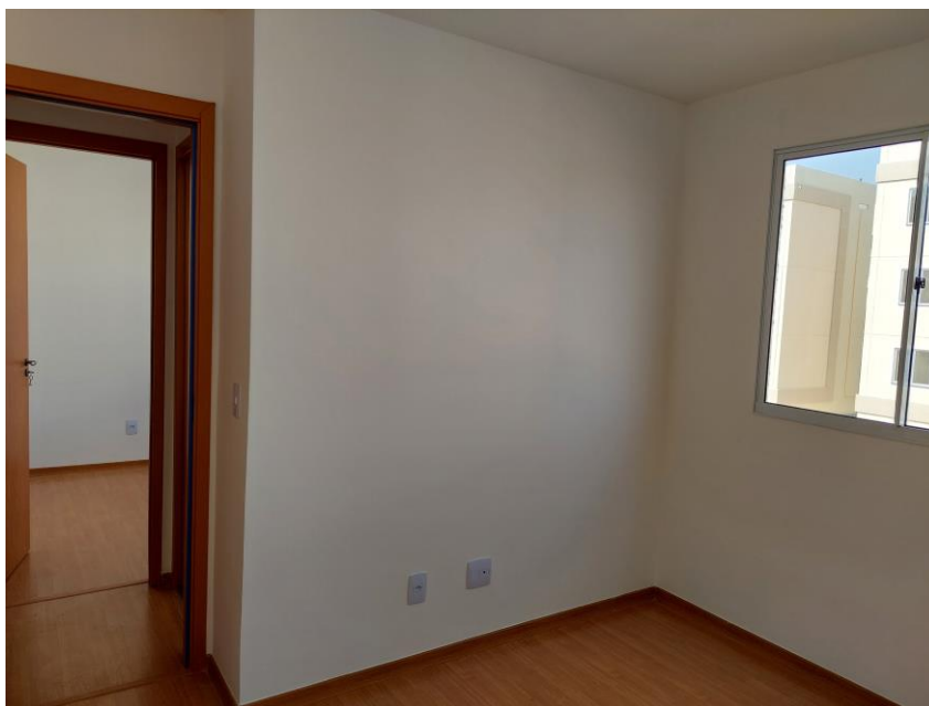
Figura 3. Quarto finalizado com gesso e pintura
