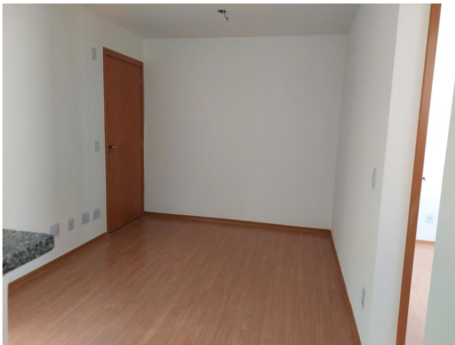
Figura 4. Sala finalizada com gesso e pintura
