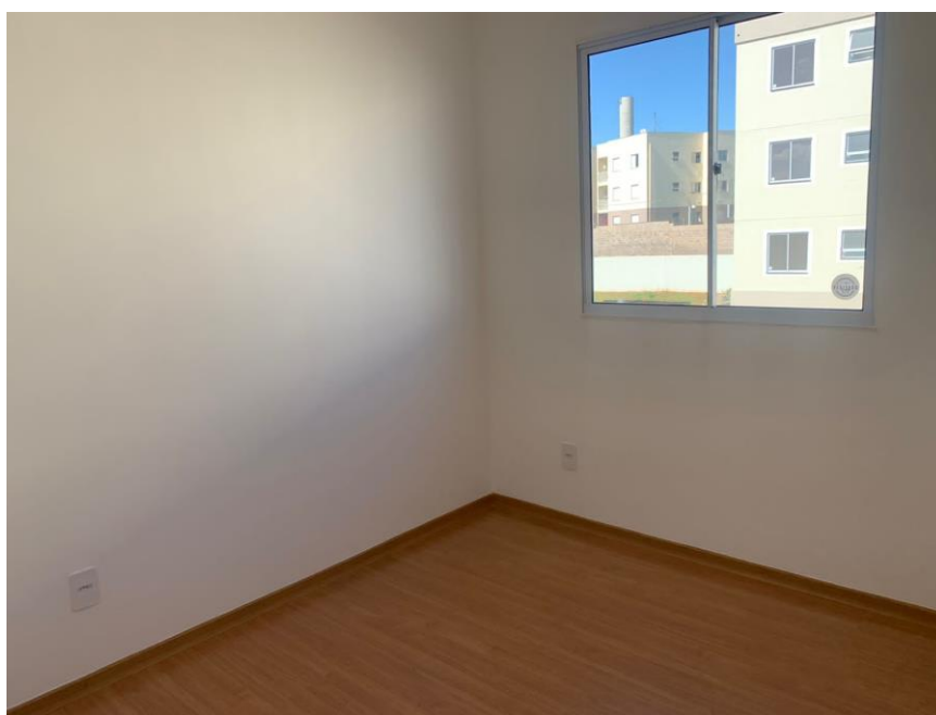
Figura 5. Quarto finalizado com argamassa cimentícia e pintura
