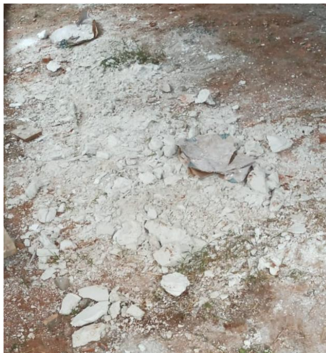
Figura 1. Resíduo gerado após a execução de um teto. Fonte: Foto da obra Cap Engenharia.
