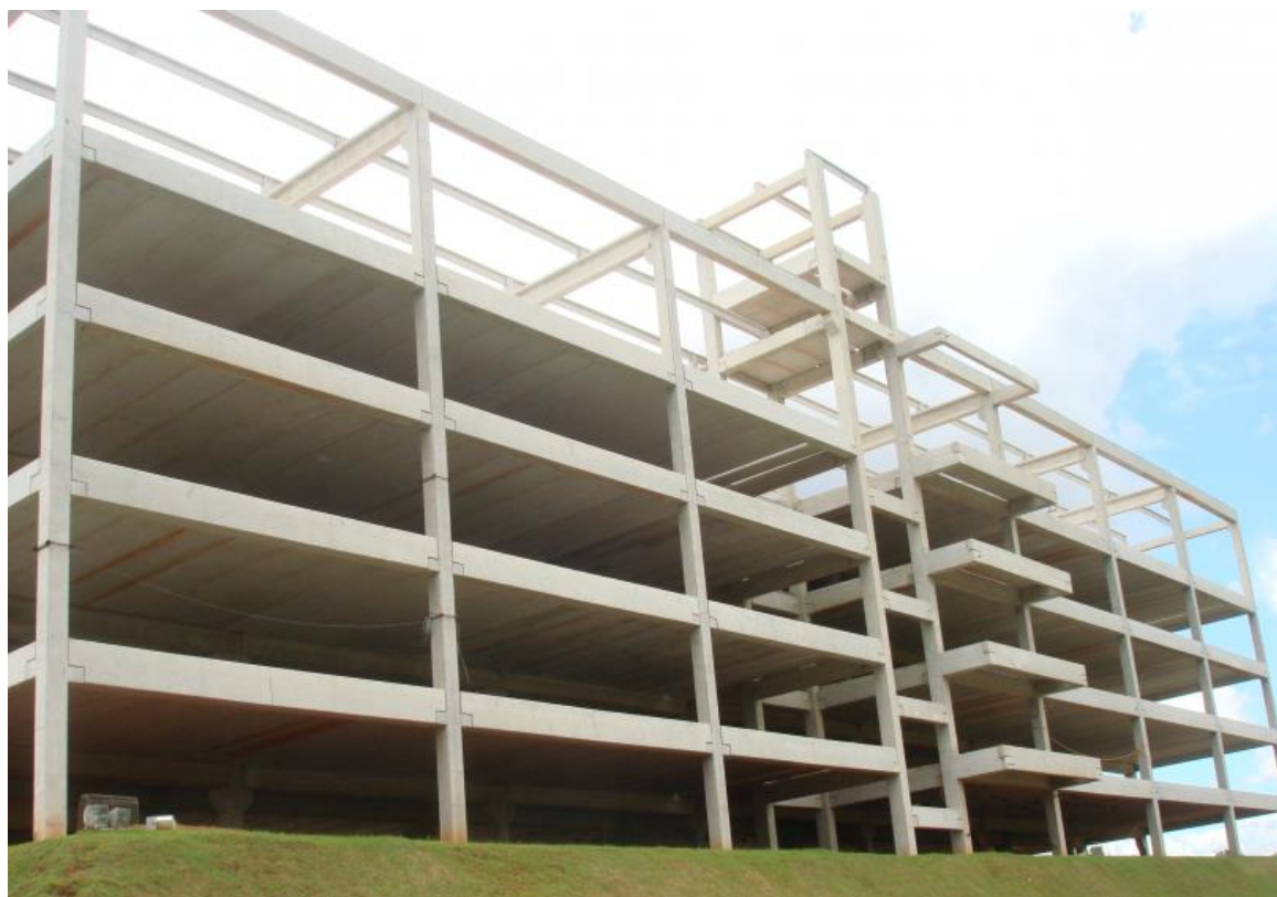
Figura 3-1 Edifício em estrutura pré-moldada.
