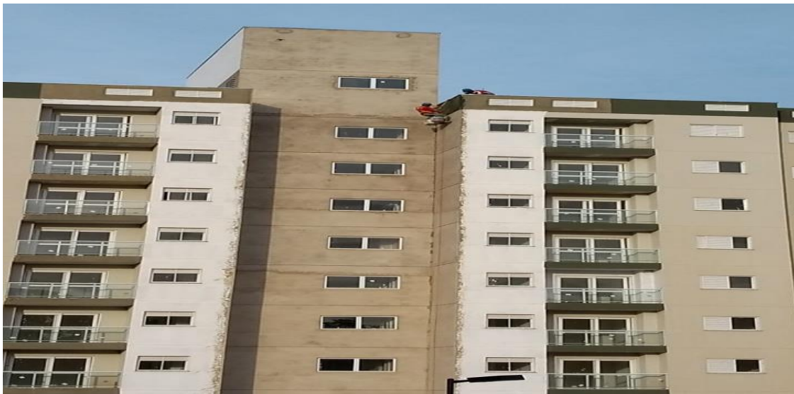
Figura 01: Dois trabalhadores como previsto na norma nessa situação, no alto do edifício usando a cadeira suspensa.
