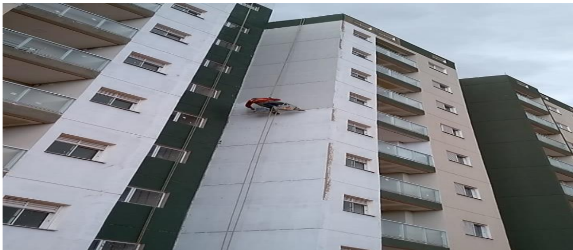
Figura 02: Um trabalhador usando a cadeira suspensa executando a pintura da fachada
