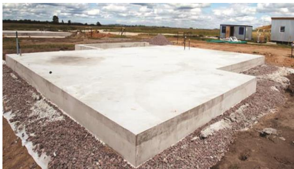
Figura 11- Fundação em radier
