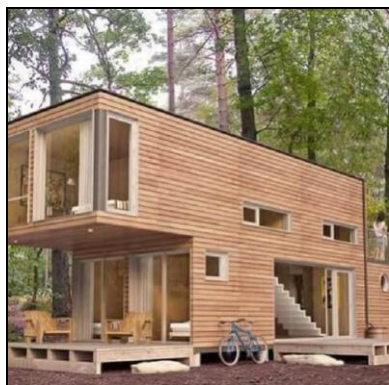
Figura 5 - Casa container revestida A
