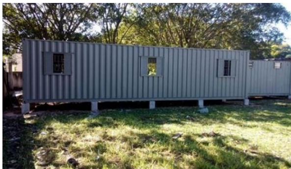
Figura 12- Fundação em estaca
