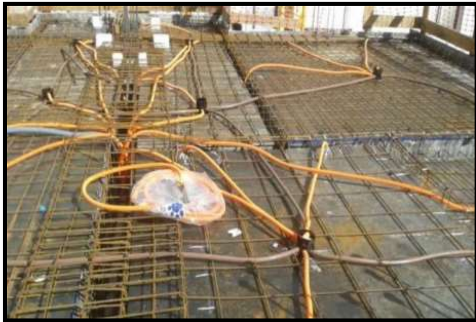
Figura 9. Eletrodutos e caixas de passagem na fôrma. (Fonte: BRANDALISE e WESSLING, 2015).
