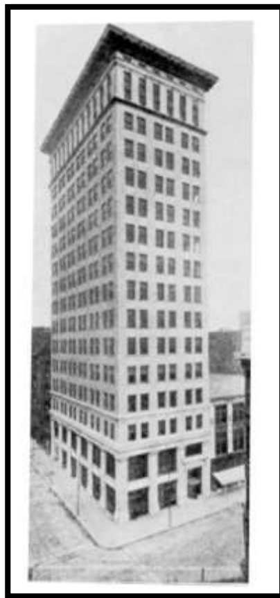
Figura 3. Ingalls Building, o primeiro arranha céu em concreto armado. (Fonte: KAEFER, 1998).
