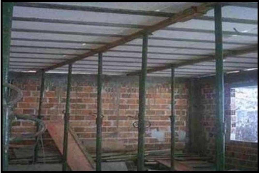
Figura 13. Escoramento de lajes pré-moldadas. (Fonte: ARAGÃO, 2007).
