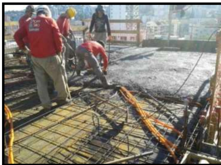
Figura 10. Lançamento e regularização do concreto. (Fonte: BRANDALISE e WESSLING, 2015).
