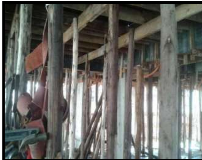
Figura 7. Escoramento de forma. (Fonte: BRANDALISE e WESSLING, 2015).
