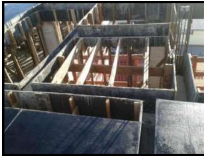
Figura 6. Fôrmas de laje maciça simples, com escoras longarinas e travessas aparentes . (Fonte: BRANDALISE e WESSLING, 2015).
