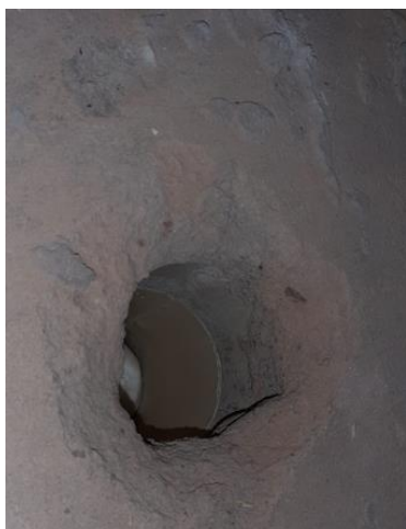
Figura 7 a) Resíduos de argamassa na superfície. Figura 7 b) Regularização inacabada.
