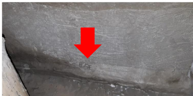
Figura 8. Tela de poliéster exposta.
