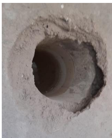
Figura 7 a) Resíduos de argamassa na superfície. Figura 7 b) Regularização inacabada.
