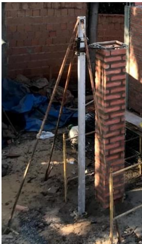
Figura 05: Pilar construído a partir do protótipo desenvolvido.
