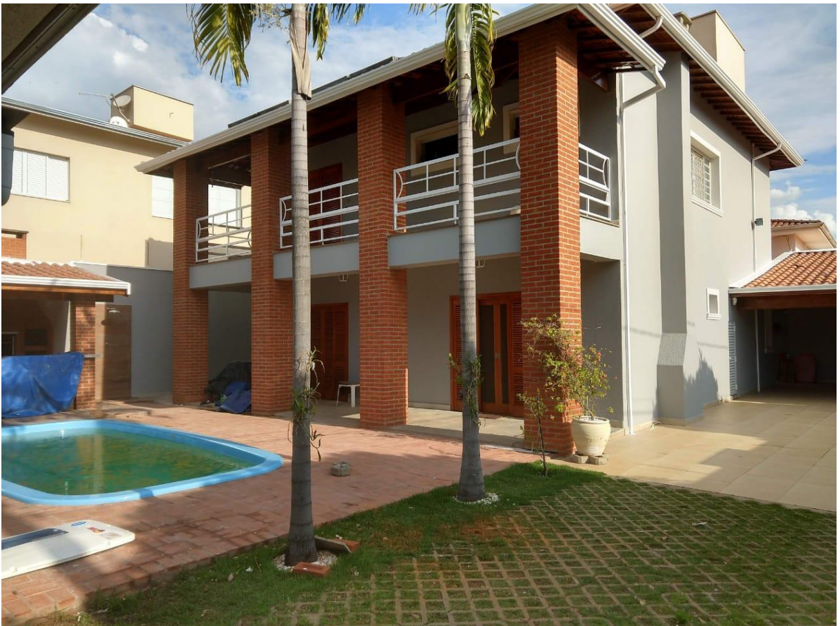
Figura 08: Término do revestimento das colunas.
