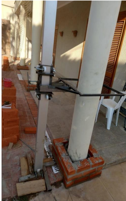
Figura 07: Revestimento de colunas
