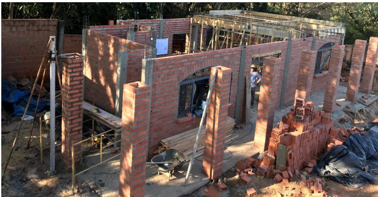
Figura 06: Pilares construídos com o protótipo com um único funcionário em dois dias.
