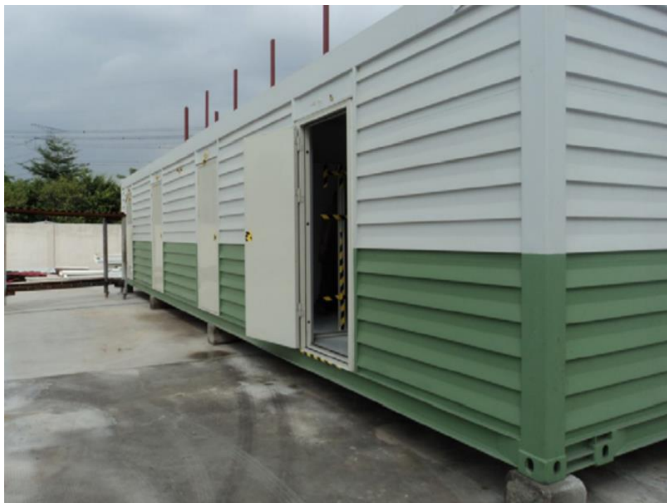
Figura 10 - Fundação em sapata do container
