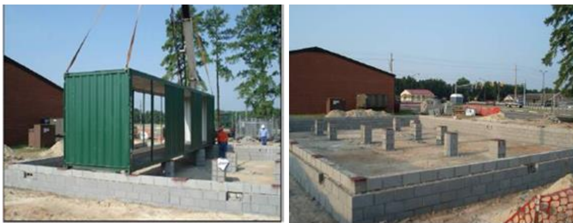
Figura 8 - Montagem da fundação
