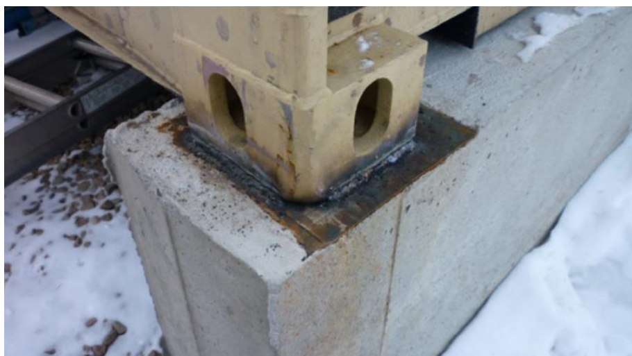
Figura 12 - Ligação de container
