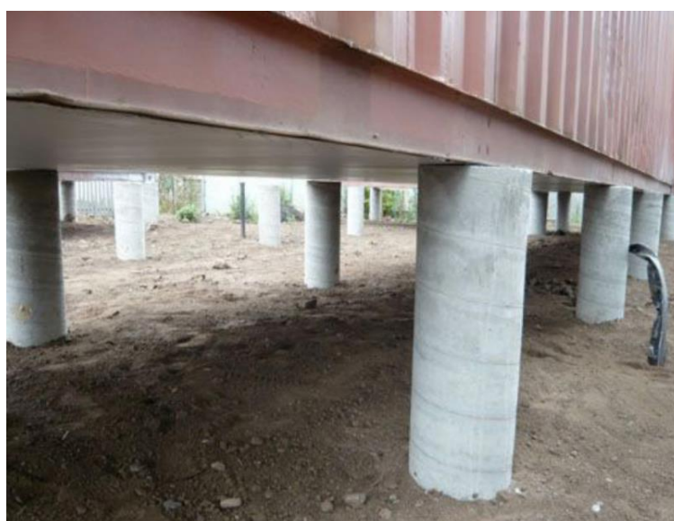
Figura 9 - Fundação do container em blocos de concreto
