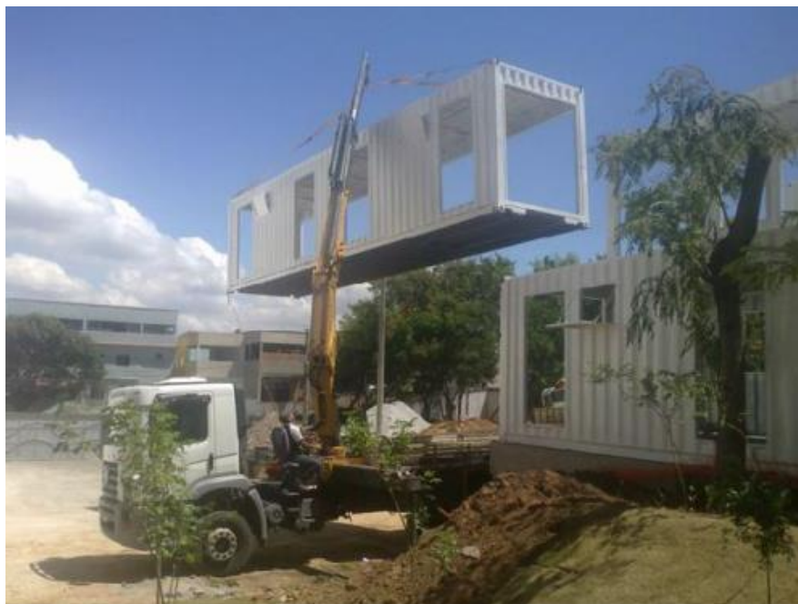
Figura 14 - Montando o container
