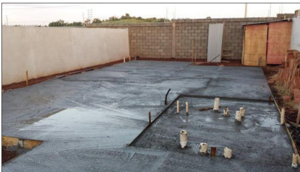
Figura 11 - Fundação do container em Radier
