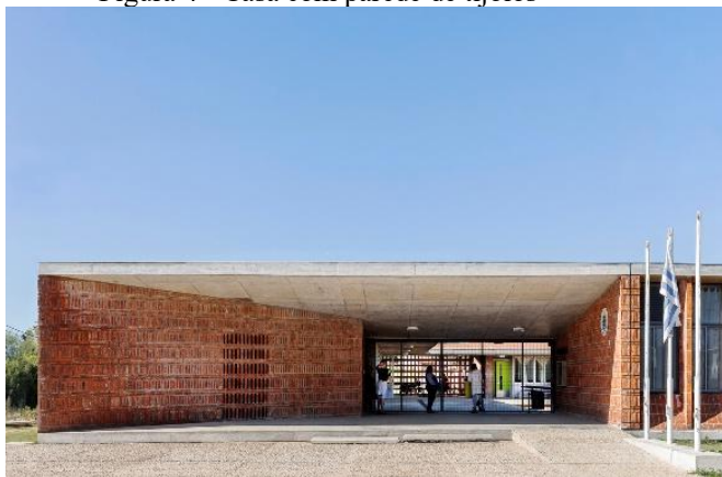
Figura 4 - Casa com parede de tijolos
