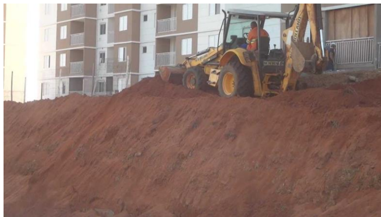
Figura 4: Serviço de aterramento de terreno
