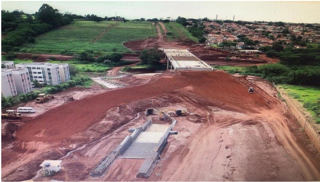
Figura 2. Vista aérea do Piscinão Córrego Cascata em execução. (Fonte: do autor).
