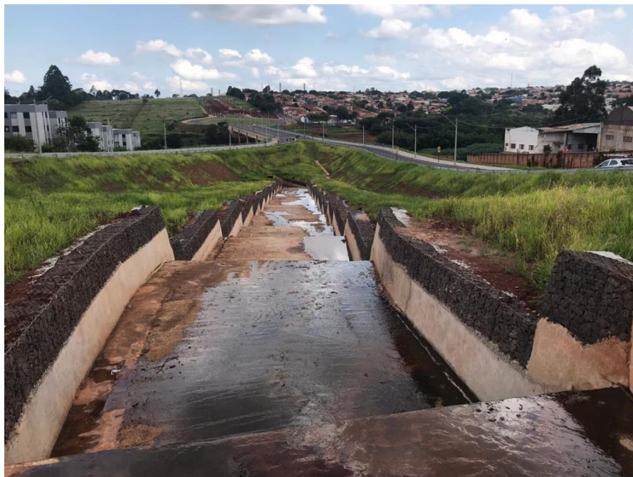
Figura 4. Piscinão Córrego Cascata finalizado. (Fonte: do autor).
