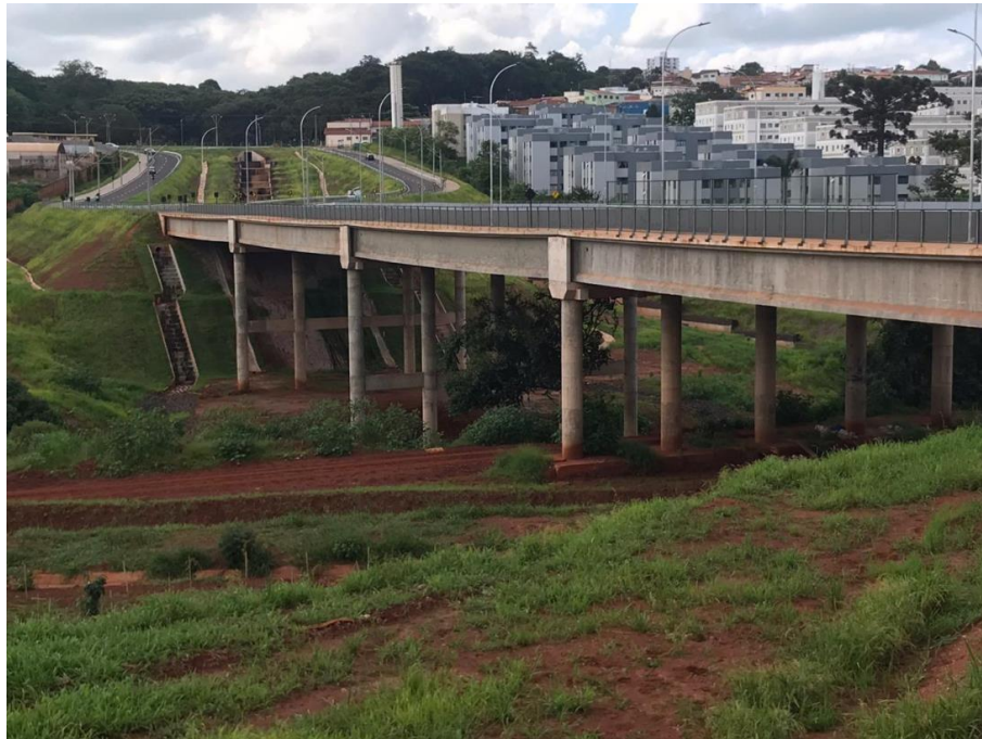
Figura 5. Viaduto onde foi realizado o aterro. (Fonte: do autor).
