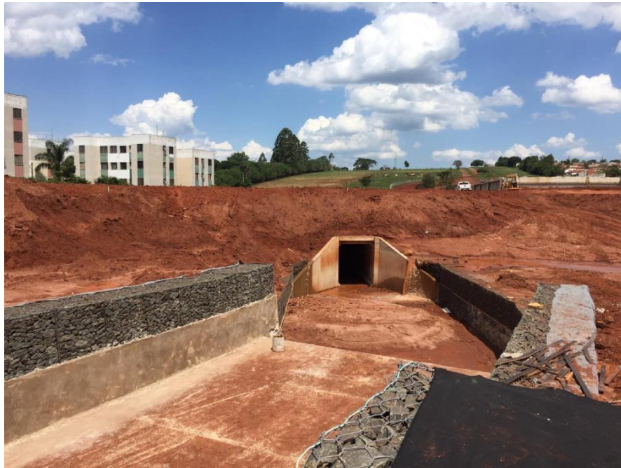
Figura 3. Piscinão Córrego Cascata em execução. (Fonte: do autor).
