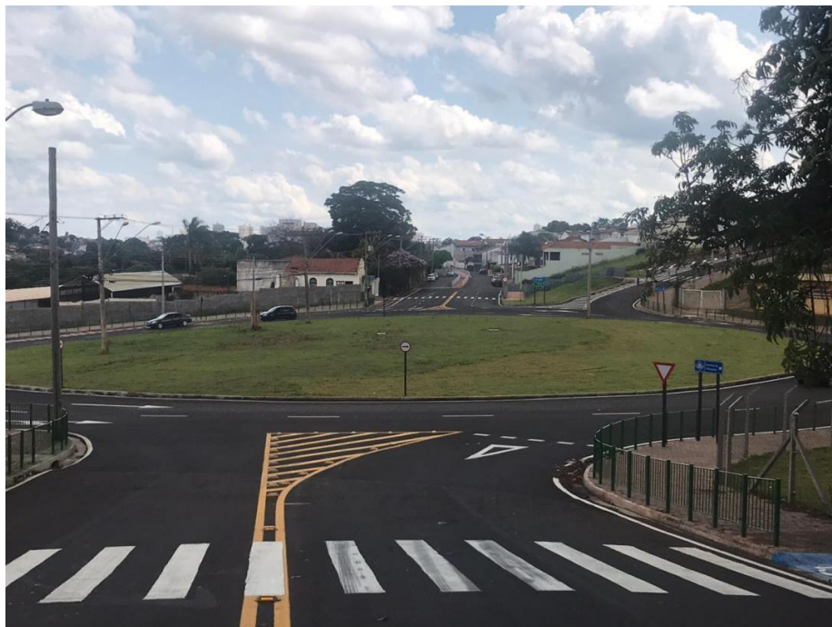
Figura 6. Rotatória onde foi realizado aterro. (Fonte: do autor).
