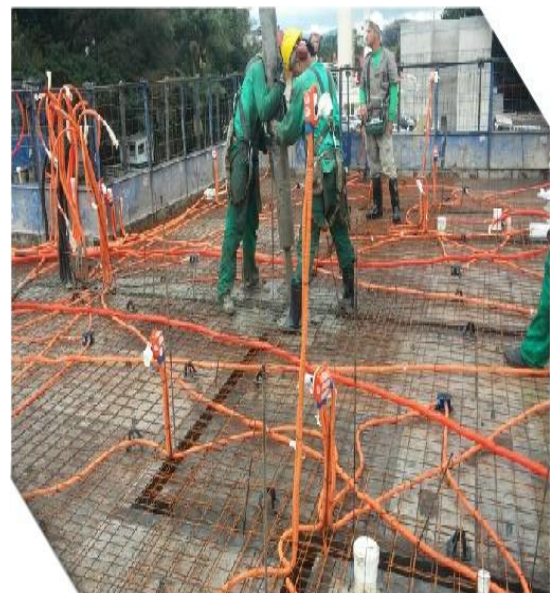
Figura 6 – Concretagem - Fonte: acervo técnico da empresa MRV-ENGENHARIA, acesso em (11/05/2020)
