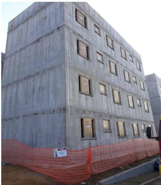
Figura 5 – Edifício construído com o método de parede de concreto - Fonte: acervo técnico da empresa MRV-ENGENHARIA, acesso em (11/05/2020)
