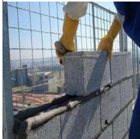
Figura 4: Assentamento dos blocos
