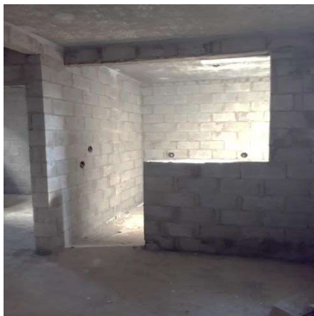
Figura 3: Apartamento em Alvenaria Estrutural
