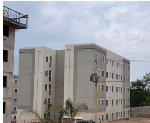
Figura 8 – Edifício construído com o método de parede de concreto com a pintura externa concluída
