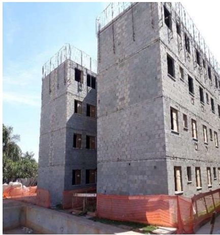
Figura 2: Torre em alvenaria estrutural
