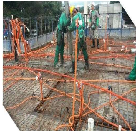
Figura 6 - Concretagem
