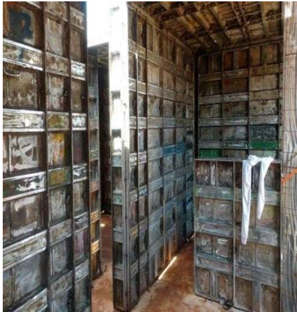
Figura 5 – Fôrmas metálicas montadas
