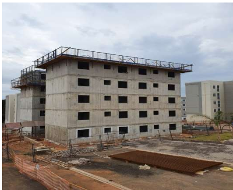
Figura 7 – Edifício construído com o método de parede de concreto
