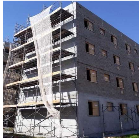
Figura 1: Execução Reboco Externo
