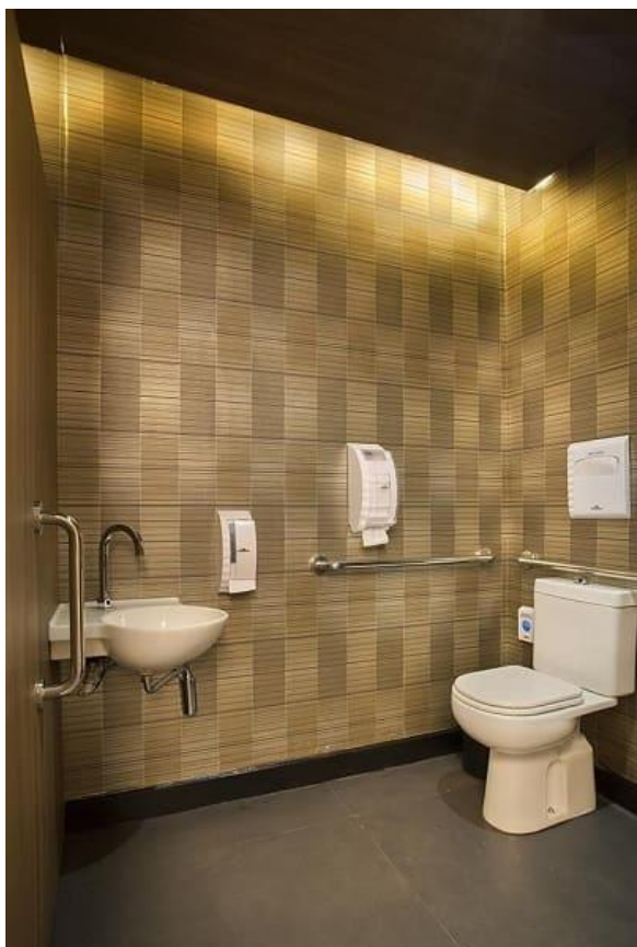
Figura 6: Exemplo de banheiro acessível
