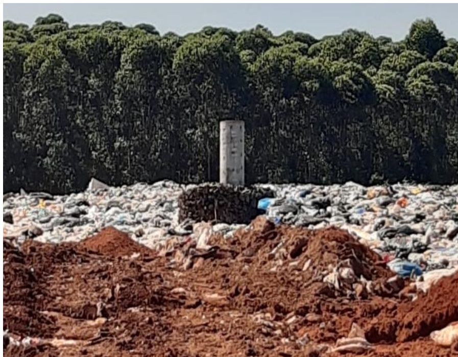
Figura 19. Dreno vertical de gás
