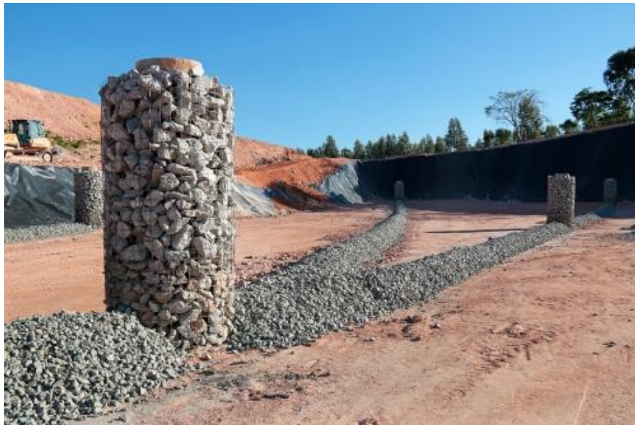
Figura 8. Sistema de drenagem de gases
