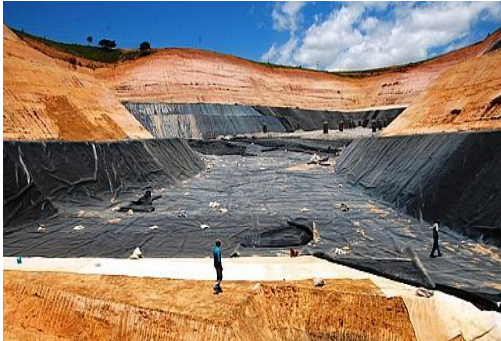
Figura 3. Impermeabilização de um aterro sanitário com geomembrana
