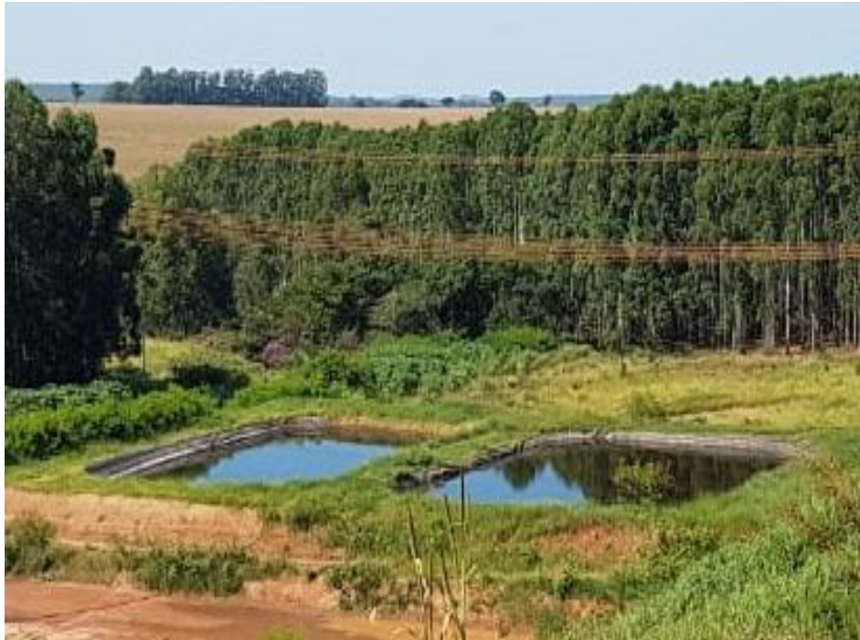
Figura 20. Lagoa de acumulação do chorume
