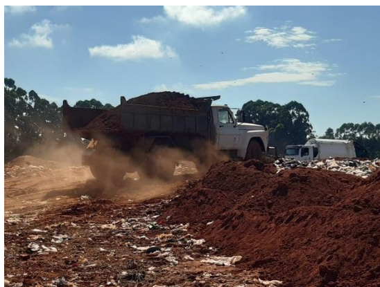
Figura 18. Terra para compactação
