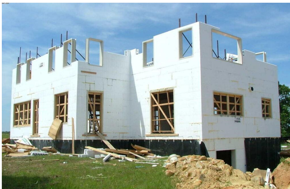
Figura 1. Construção de casa com tecnologia ICF
