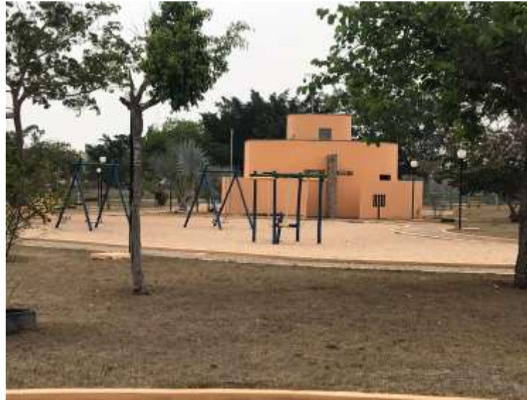
Figura 3: Pode-se observar o Parque de recreação com a infraestrutura atual.
