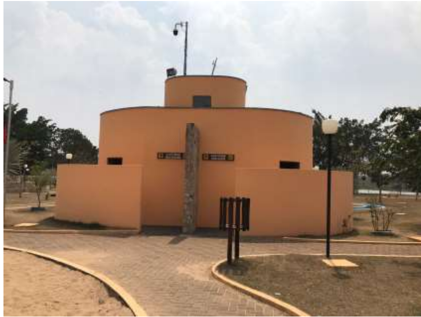
Figura 6: Pode-se observar os sanitários com a infraestrutura atual.
