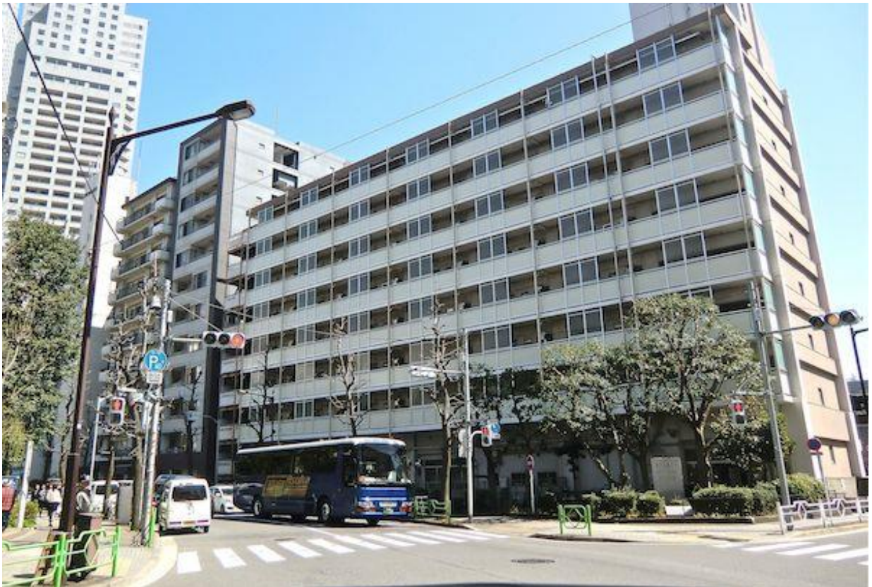
Figura 10: Prédio de apartamentos do tipo Koei jutaku em Tóquio. (BRASOR; TSUBUKU, 2015).
